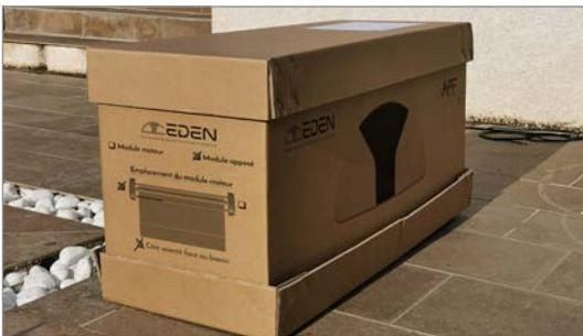
Positionnez les cartons des modules de chaque côté du bassin. Identifiez le positionnement des 2 modules grâce aux marquages renseignés sur les cartons.
